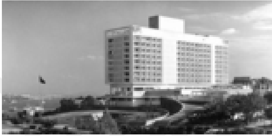
Şekil 4.26 Hilton Oteli 1955. 1952-1955 seneleri arasında inşa edilen bölümü
