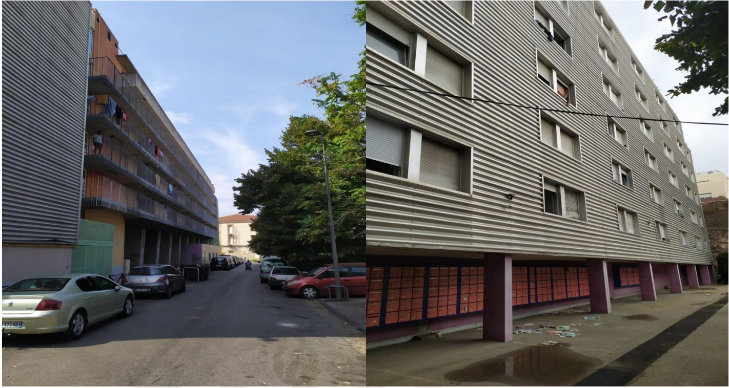
Ek 2: Fransa’da Arařtırmanın Yapıldıđı Sosyal Konut Binasının Dıřarıdan Grnř.
